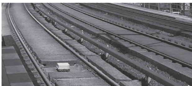
Figura 13: Absorvedores de betão madeira dispostos entre os trilhos da linha de trem em Berlim
