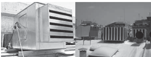
Figura 6: Exemplos de silenciadores resistivos.
