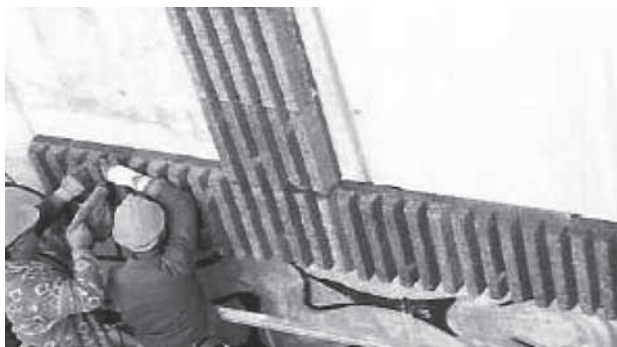
Figura 10: Construção de uma barreira acústica com revestimento de betão madeira, Fonte [3].
