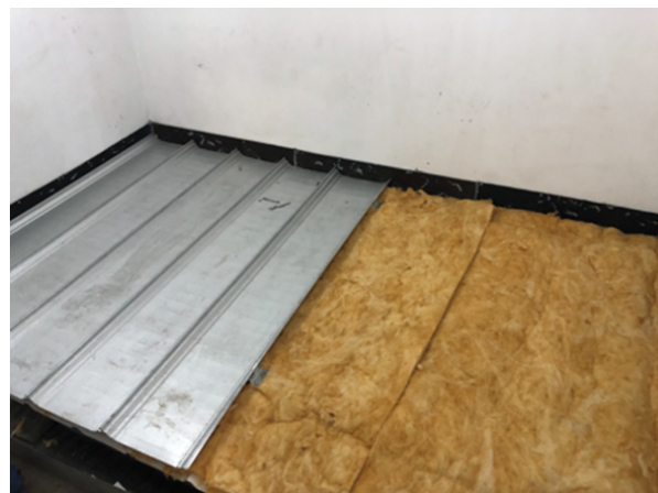
Figura 11: Instalação da telha zipada.
