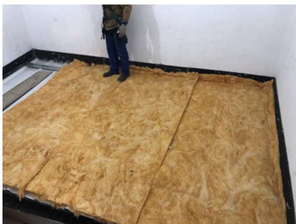
Figura 10: Instalação da lã de vidro para os sistemas compostos.
