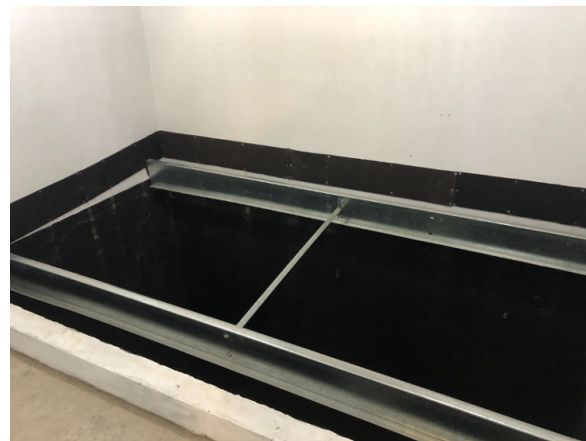
Figura 2: Espaço para instalação das amostras.
