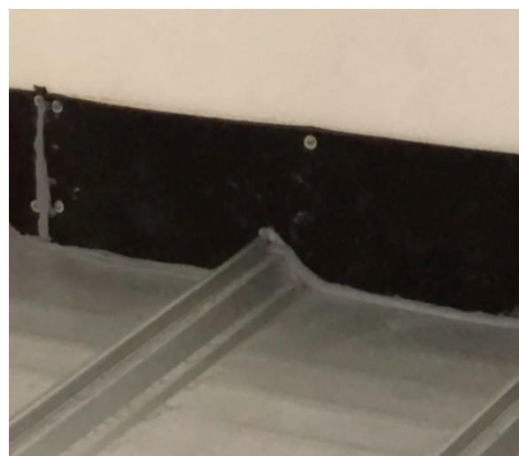
Figura 3: Selante aplicado nas juntas entre a telha e o EVA.
