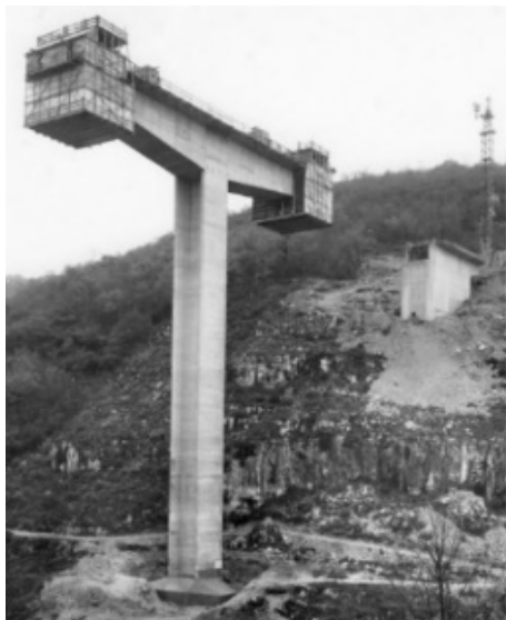
Figura 14: Ponte de la Pyle na fase de construção, da qual se observa o pilar em duplo T com abas constantes (retirado de Pilar da ponte de la Pyle [69]).
